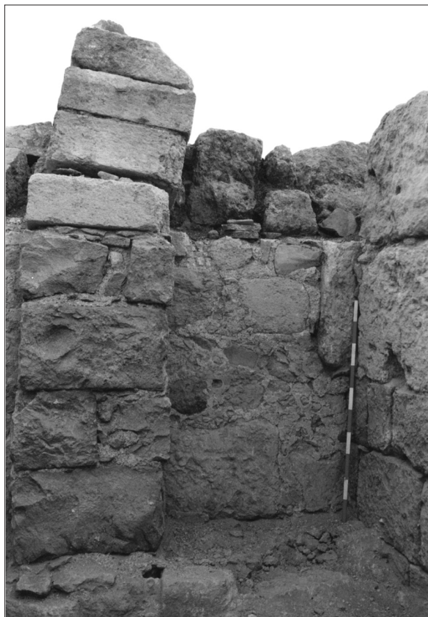
Fig. 7. Pomieszczenie L 207: narożnik północno-wschodni. Fot. J. Burdajewicz
