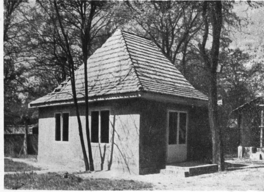
Dom mieszkalny z elementów trzcinowo-drewnianych, kryty dachówką, otynkowany zewnątrz i wewnątrz. Produkcja tych elementów na kompletne zestawy budynków jest przewidziana przez Zarząd Przemysłu Wikliniarsko-Trzcinlarskiego w roku 1955. Foto F. A. Czełny.
