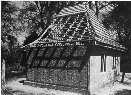
Domek tego typu w budowie, z uwidocznieniem ściany trzcinowo-drewnianej i wiązania dachowego. Foto F. A. Czełny.
