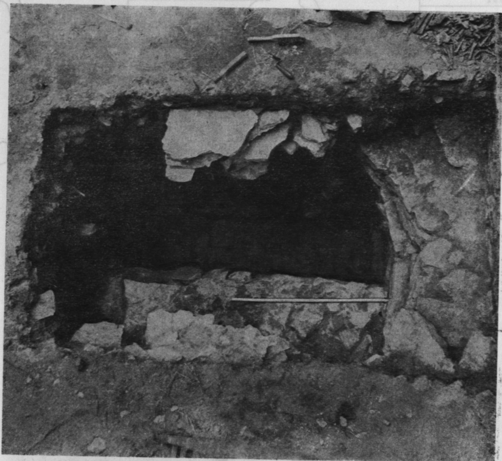
Ryc. 10. Małogoszcz, st. Kościół. Płyta z zaprawy wapiennej
